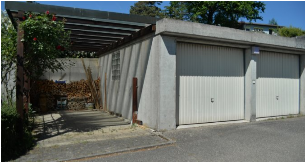
Doppelgarage und Carport
