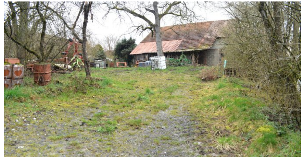
Scheunengebäude von hinten
